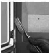
**3** 布を水に濡らしてきつく絞り、溝に残った耐火セメント、もしくはシールの削り粉などをきれいに掃除し、下地を整えます。
