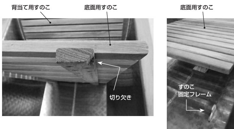
最後に「ストーブ仕切り用すのこ」の金属プレートと浴槽のすのこ固定フレームの位置を合わせ、ボルト・ナットを固定してください。
