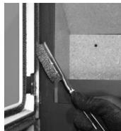
**3** 布を水に濡らしてきつく絞り、溝に残った耐火セメント、もしくはシールの削り粉などをきれいに掃除し、下地を整えます。
