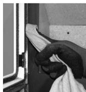
**4** ファイバーロープを納める溝に直径約3mmの太さで耐火セメントを注入します。
